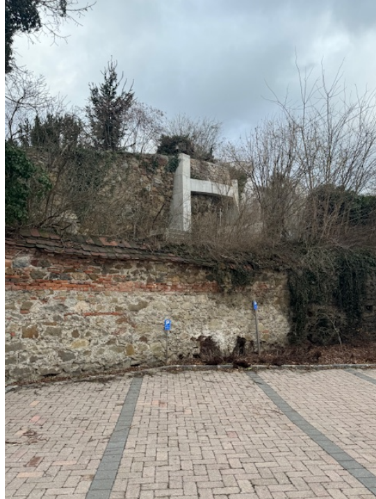
Vorschläge einer Verkleidung für die notwendige stat. Abstützung an der historischen Schlossmauer
