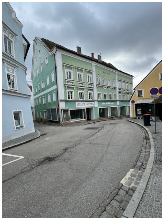
Begleitende Kontrolle beim Abriss und Neubau des Haas Hauses
